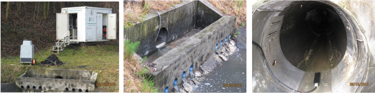
Abbildung 120: Probenahme beim Autobahnregenbecken Mönchgraben an der A1 (Zulauf)
