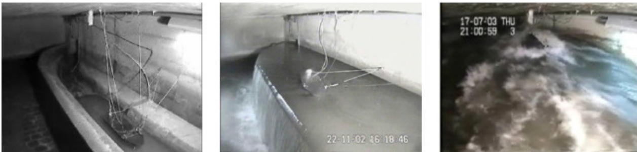
Abbildung 53: Ponton mit UV/VIS-Spektrometer der MS Graz bei unterschiedlichen Abflussverhältnissen im Kanal
