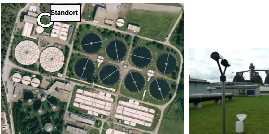
Abbildung 83: Orthofoto und Standort der Niederschlagsammeleinrichtung auf der RKL Linz-Asten ( maps.google.at , Zugriff: 2012-09-18)
