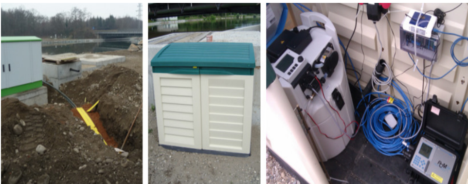
Abbildung 119: Arbeiten zur Herstellung eines Stromanschlusses (links) und Kunststoffbox mit den Geräten der Messstation (mitte und rechts) im Untersuchungsgebiet 5
