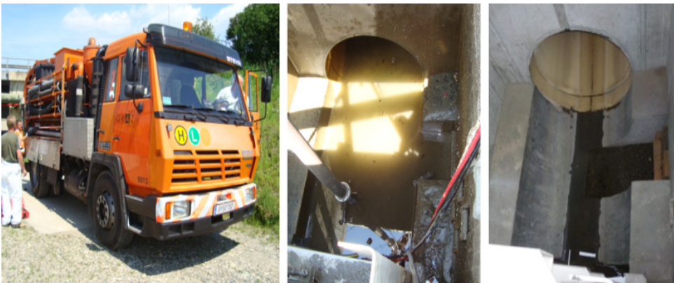
Abbildung 117: Vorarbeiten vor der Sensorinstallation im Kontrollschacht des Straßenabwasserkanals vor der Einleitung in die Mur. Links: erforderlicher Saugwagen zum Auspumpen des eingestauten Kanals. Mitte und rechts: Ausgepumpter Kontrollschacht mit Zulaufkanal.
