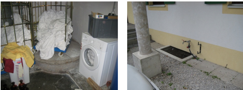
Abbildung 95: Schachtbrunnen im Waschkeller der GZÜV-Messstelle und Probenahmestelle.
