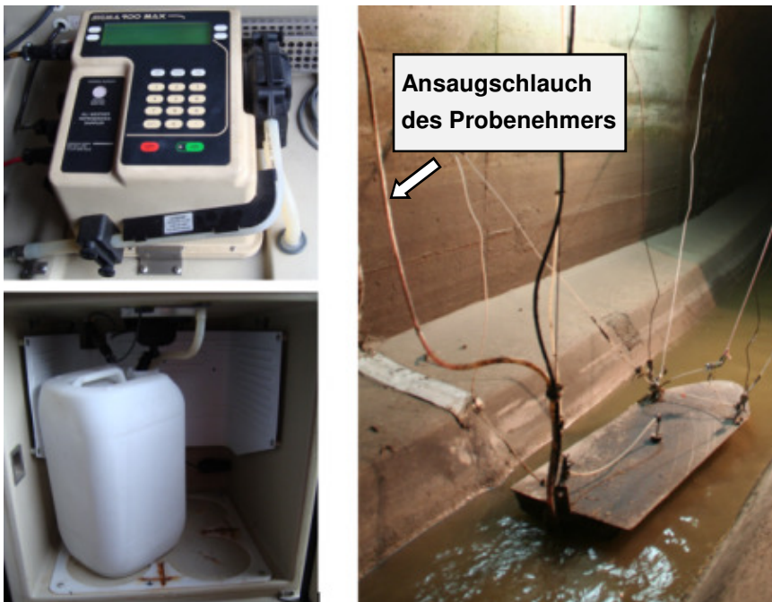
Abbildung 109: Probenahmegerät American Sigma 900 MAX und am Pontonheck installierter Ansaugschlauch der Messstation Graz
